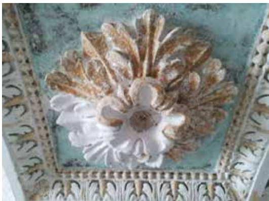
Stucchi dell'arco Trionfale fine sec. XVI inizio sec. XVII descialbatura meccanica con recupero della policromia
